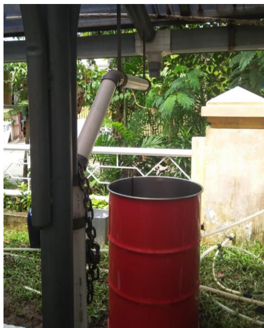
Gambar 4.2 Penampungan Air Hujan
