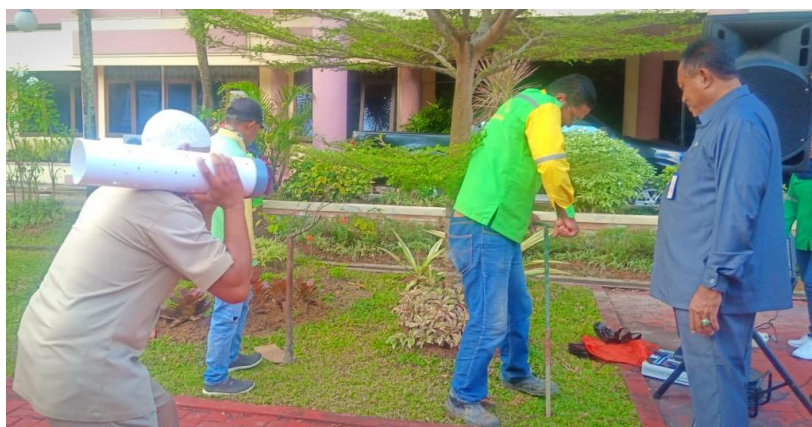
Gambar 4.6 Proses Pembuatan Biopori
